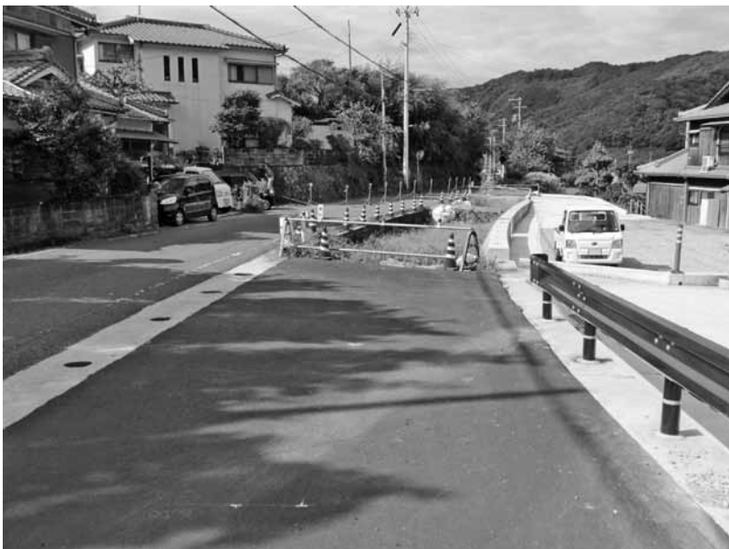
拡幅改良中の県道（原谷地内）
