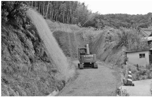
早期の完成が望まれる避難道路(比井)
