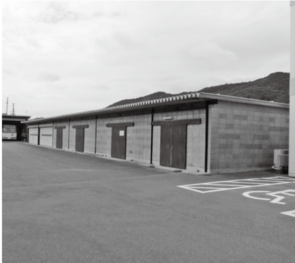
移転新築される水防倉庫
