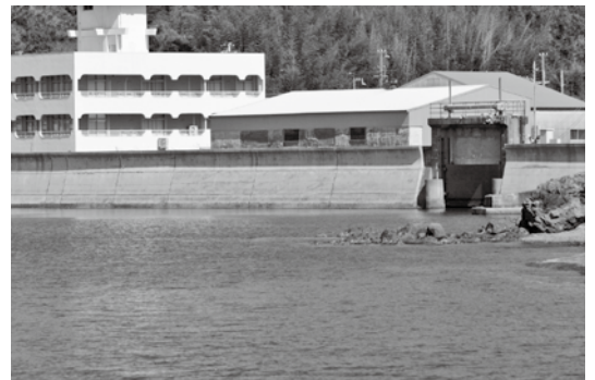
町内の防潮堤
