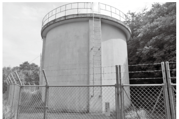
防災倉庫設置予定場所（小浦）
