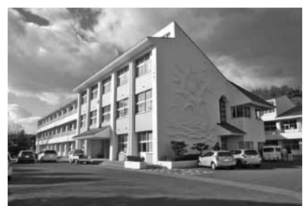
改修が完了した日高中学校
