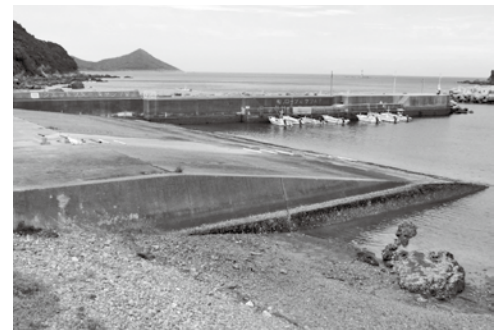
転落防止柵を設置する船揚場
