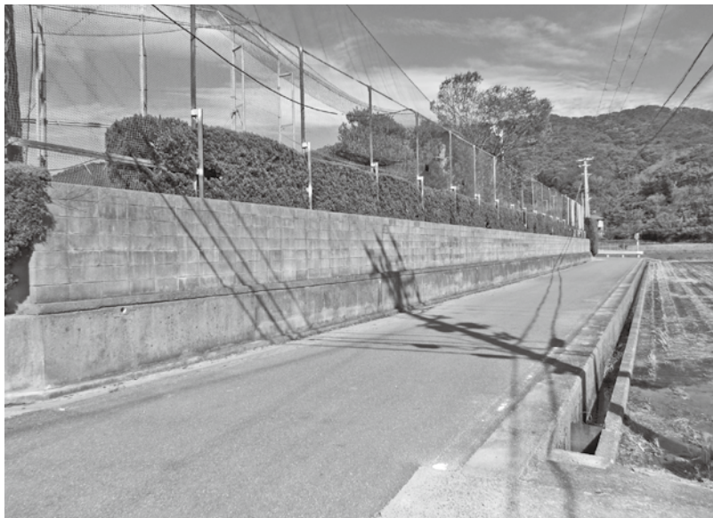
撤去、改修される志賀小学校のブロック塀
