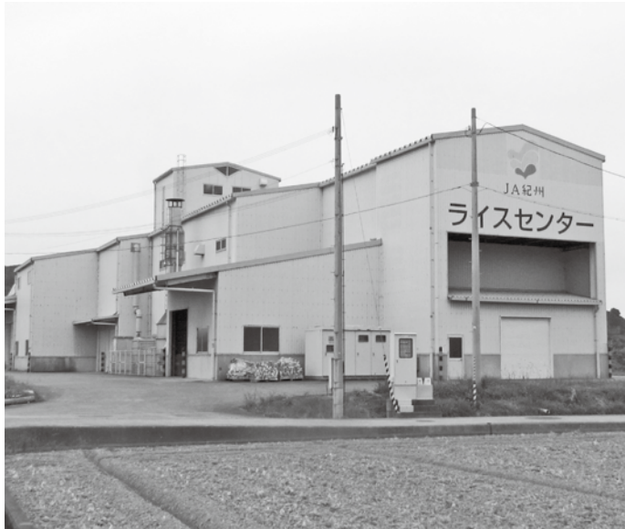
改修される新ライスセンター
