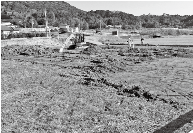
造成中の志賀小学校駐車場
