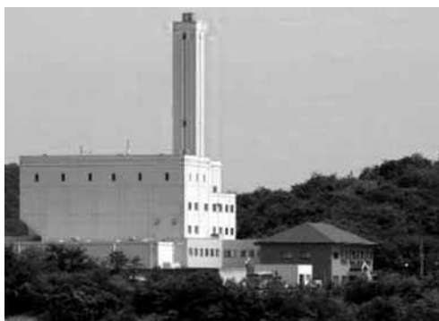
大規模修繕が予定されている清掃センター
