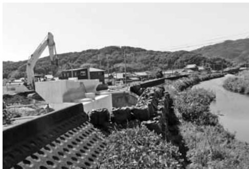
橋梁工事現場
