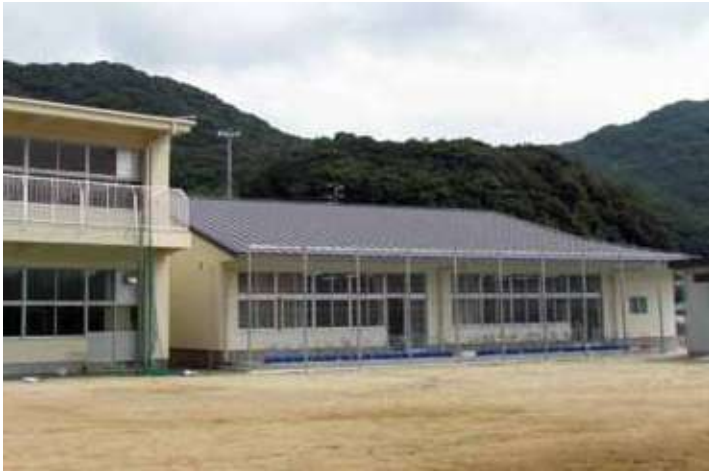
増改築した志賀小学校
