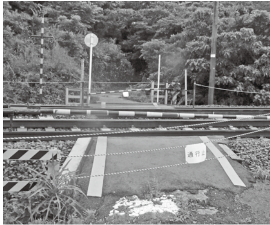
廃止された踏切（池田地内）
