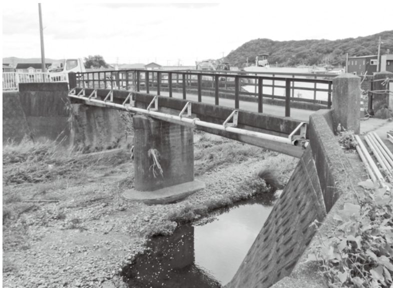
撤去される天満井橋
