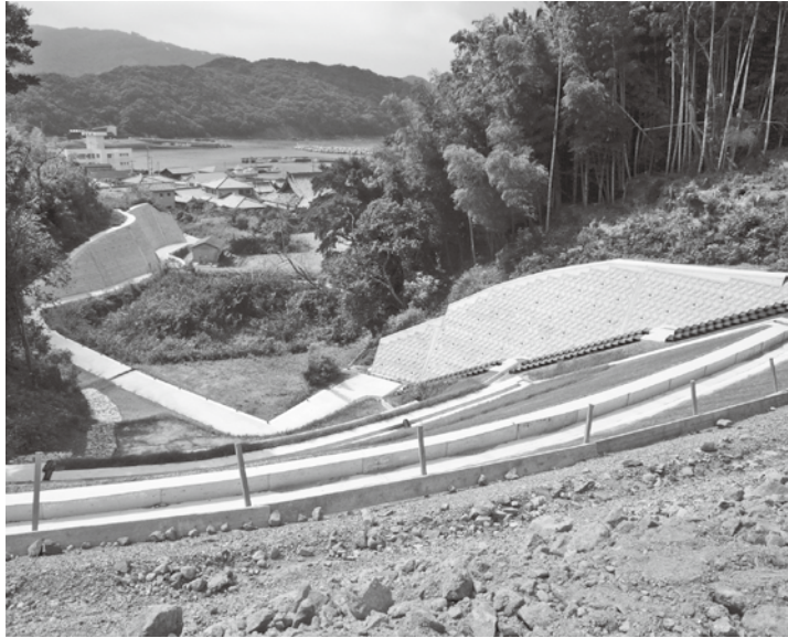
完成間近の比井漁港集落道改良工事
