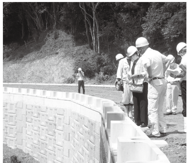
補強土壁工
