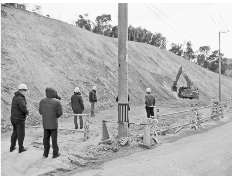
県道拡幅工事 (阿尾〜田杭間)
