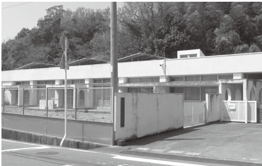
改修工事をする比井崎集会所（旧比井保育所）
