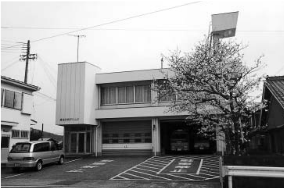
消火活動の中心となる消防庁舎
