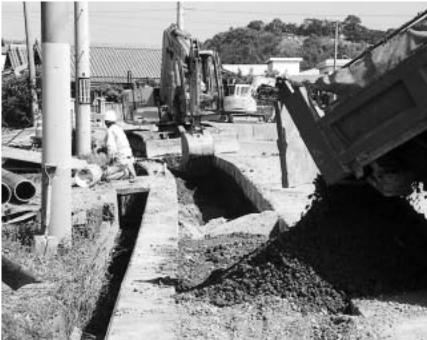
施工中の下水道事業
