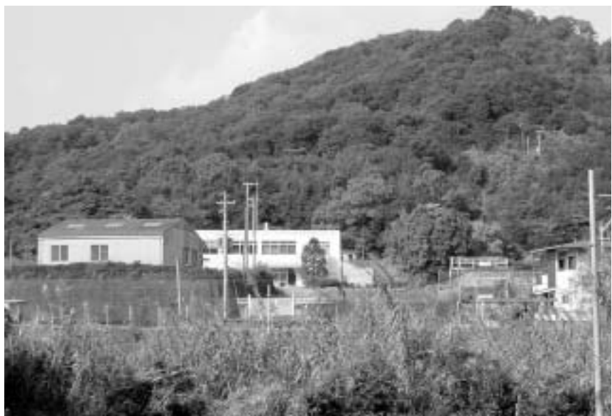
増設予定の浄水場
