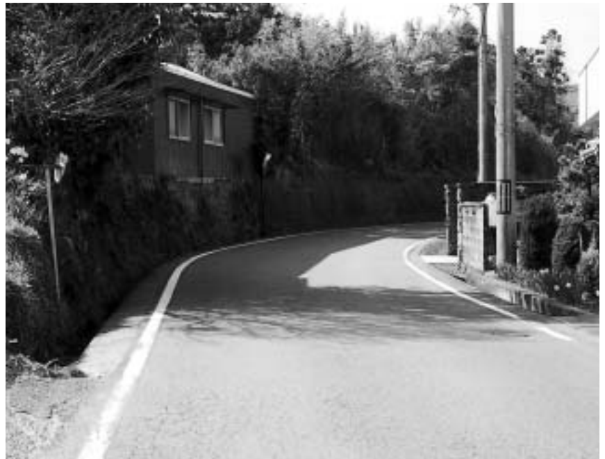
改良を待つ危険なカーブ
