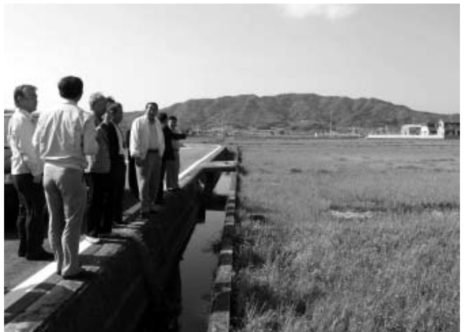
谷口・小池下水処理場建設予定地
