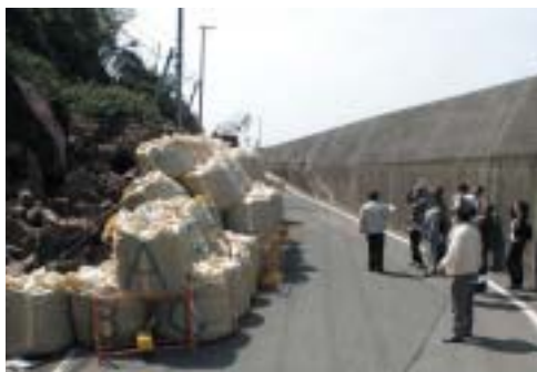
阿尾の地山崩壊現場にて
