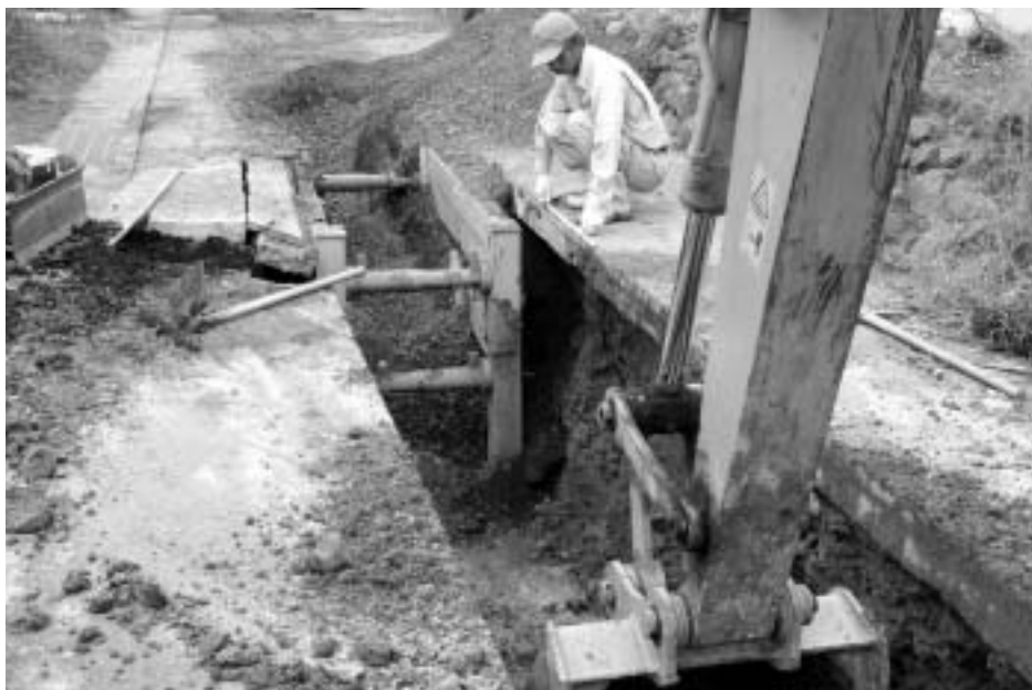
増額された下水道工事
