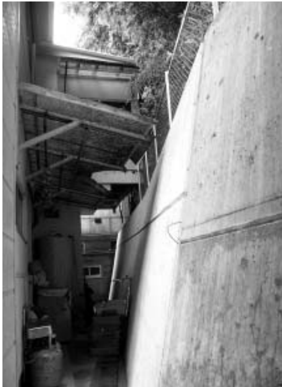
完成した崩壊対策工事
