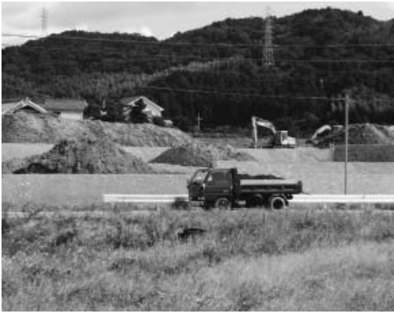
着々とすすむほ場整備工事
