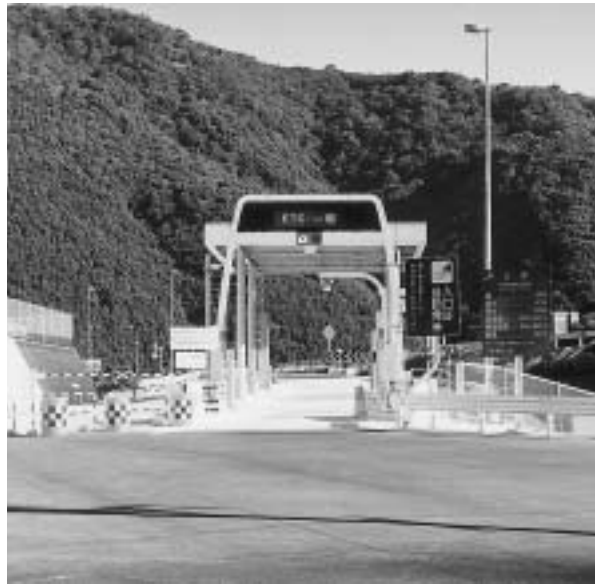
広川南インターチェンジ供用開始
