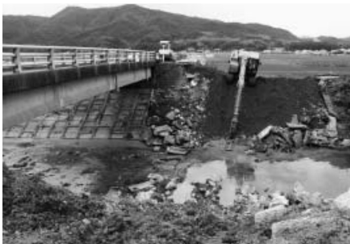
いよいよ着手 橋梁下部工事（西川大橋）
