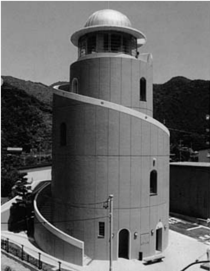
津波時の避難塔（三重県紀勢町）
