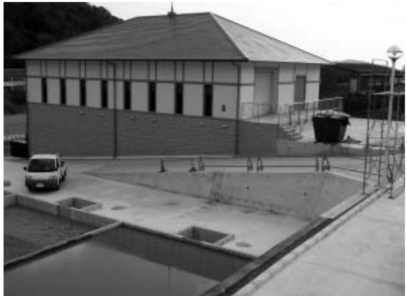
最新の処理施設を導入した萩原浄水場
