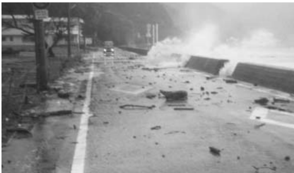
防潮堤を越え県道まで押し寄せる大波（台風23号、産湯海水浴場）
