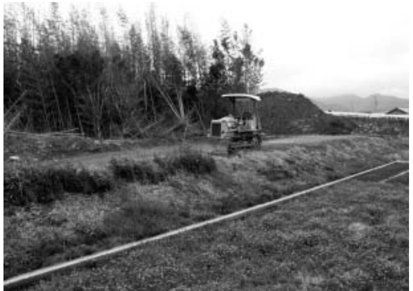
計画変更で着工まじの処理場予定地（高家地内）
