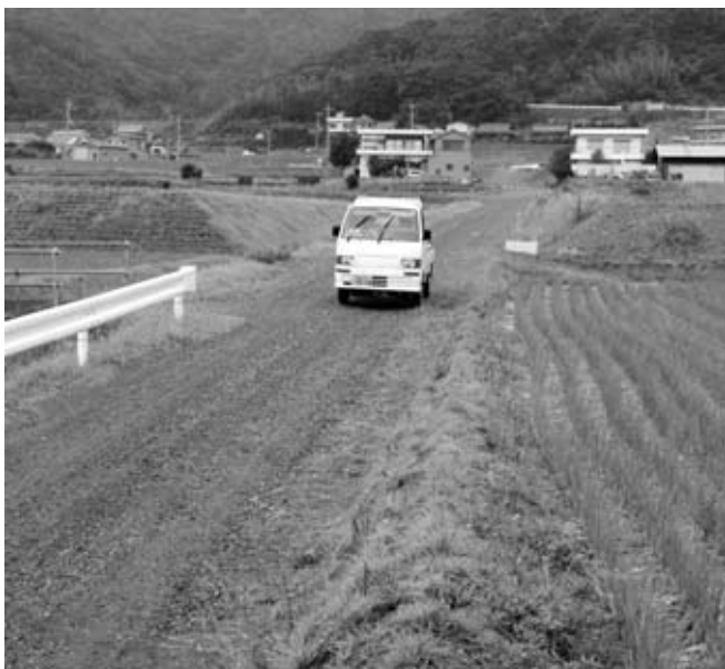
みどり 水土里の事業で舗装予定の農道(萩原地区)
