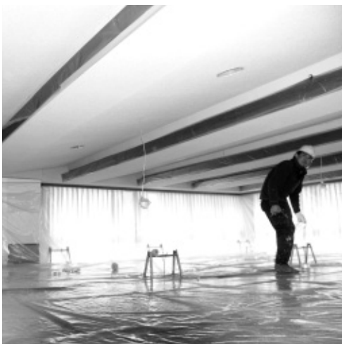
アスベスト対策工事(比井小学校)
