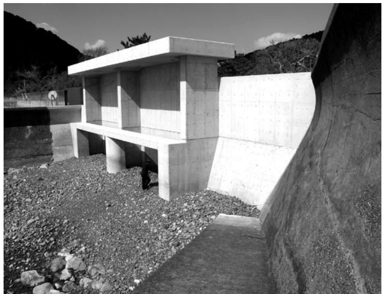
完成間近の産湯川水門
