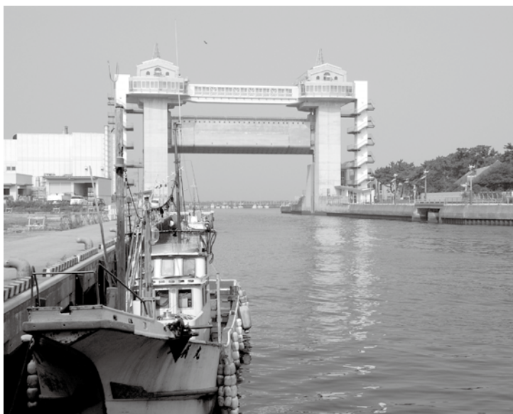
全高約40mの水門「びゅうお」（沼津市）
