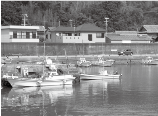
耐震診断が待たれる防潮堤（比井漁港）
