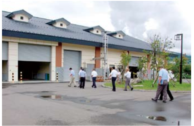
下水処理場に併設した堆肥化施設（中野市）
