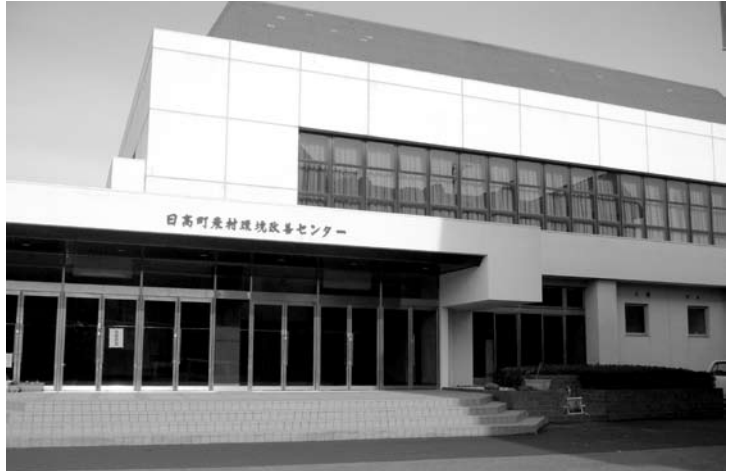
耐震補強が必要な農改センター
