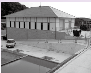
安全・安心な水を供給している萩原浄水場
