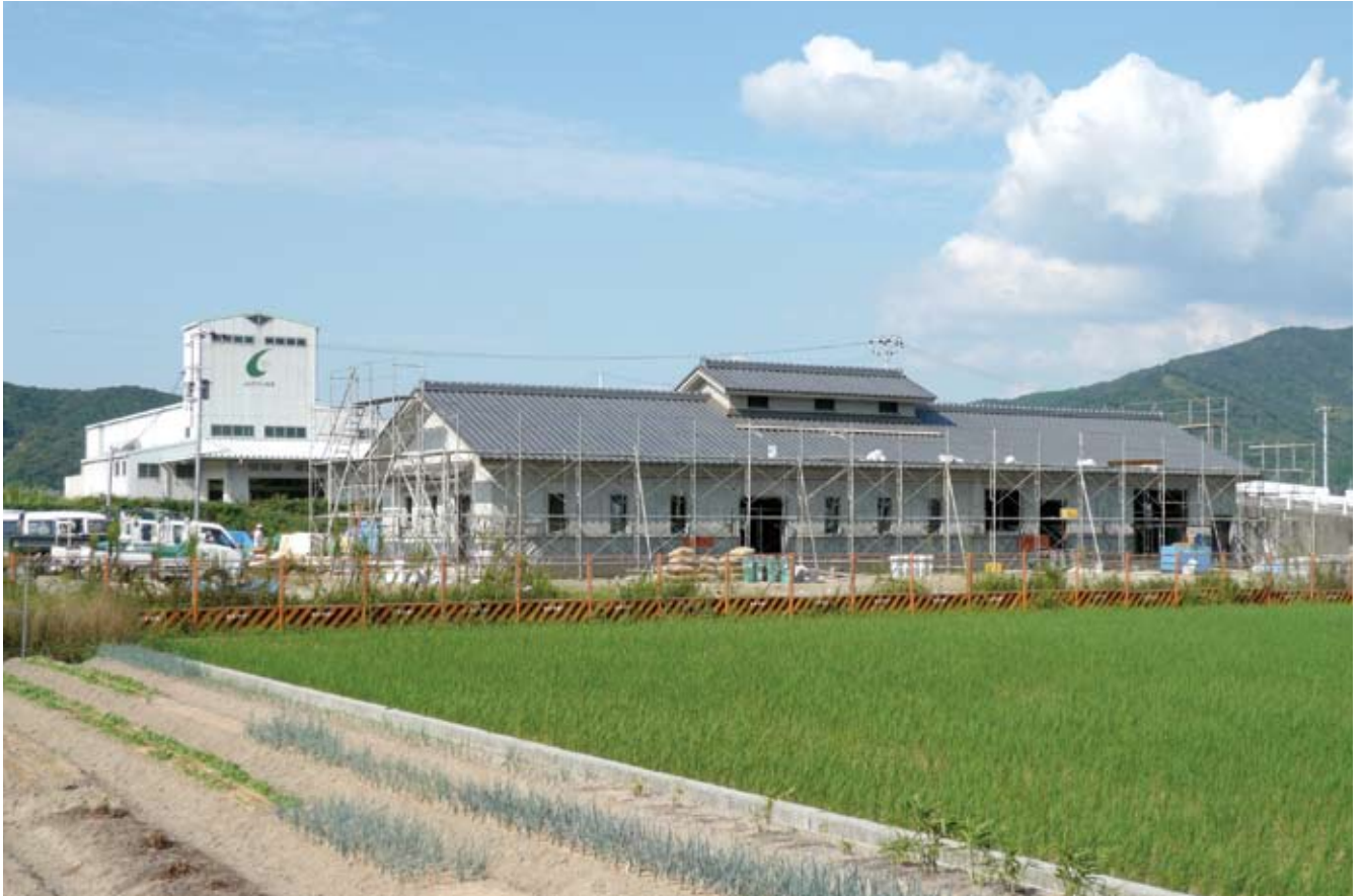
完成間近の内原東処理場
