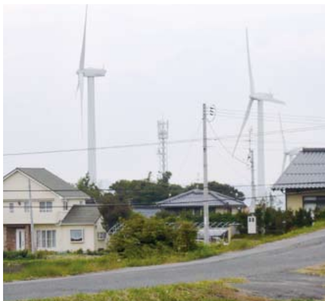
国道9号線沿いの風力発電
