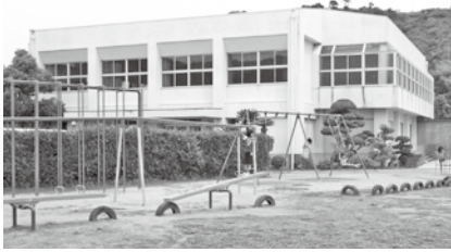
志賀小学校体育館改修
