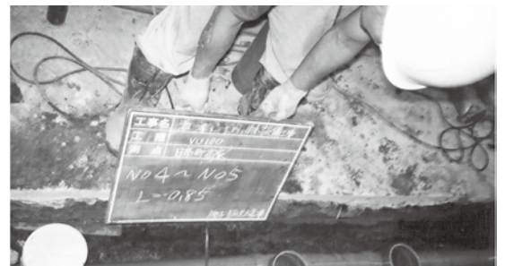
宅内工事現場
