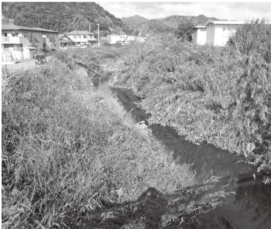
西川環境保全事業で伐採（内原小学校西）
