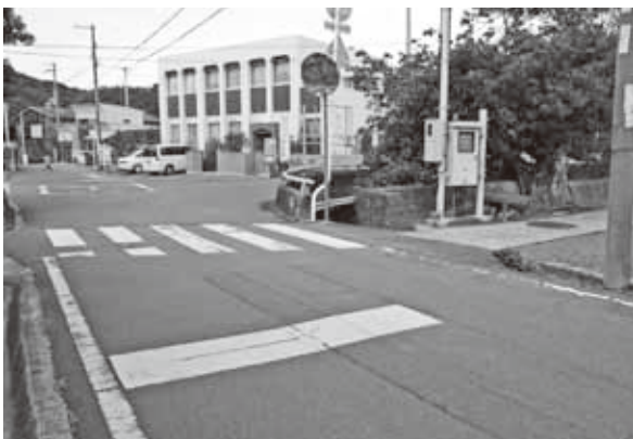
中継ポンプ移設工事（比井交差点）
