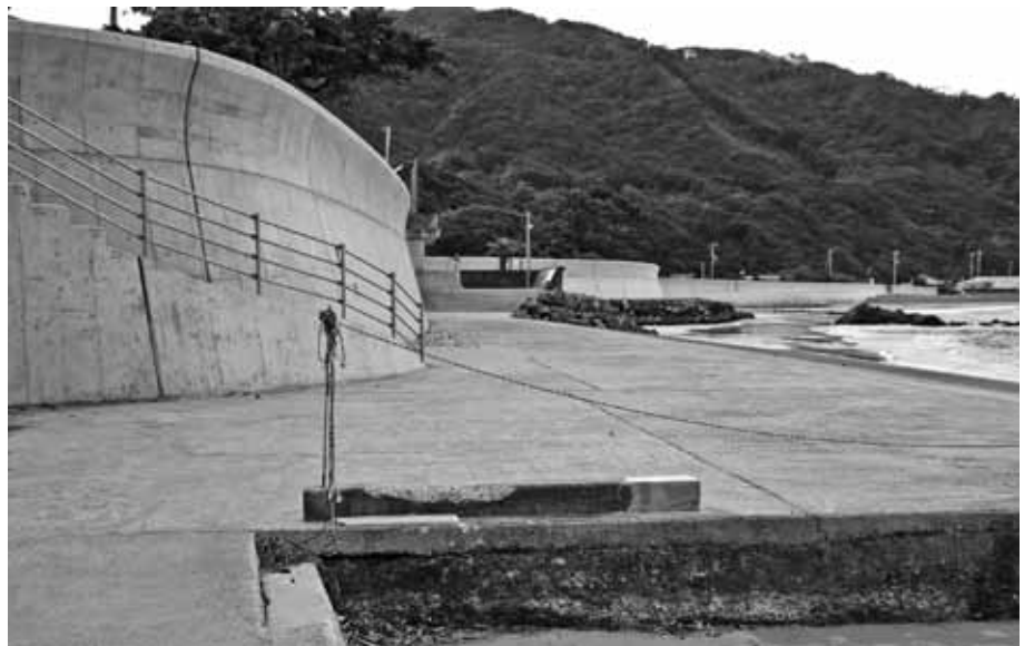
完成した産湯防潮堤補強工事
