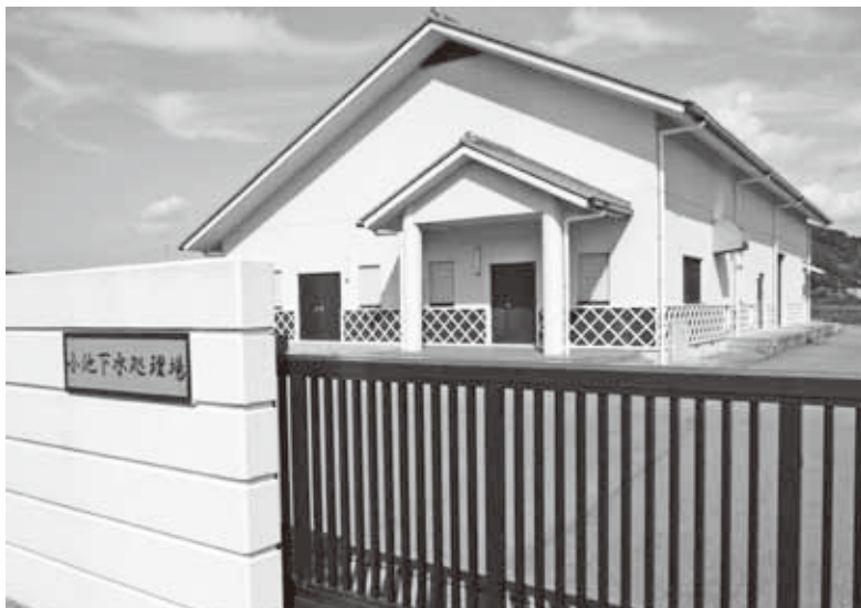
谷口小池処理場
