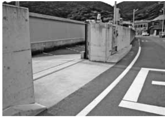
完成した阿尾陸こう鉄扉
