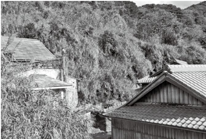
災害緊急砂防事業対象地（田杭地内）
