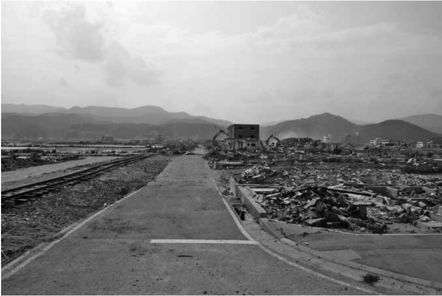
津波被害を受けた岩手県陸前高田市
