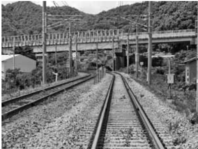
改修予定の萩原跨線橋
