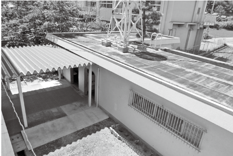
内原小学校便所棟建て替え予定地
