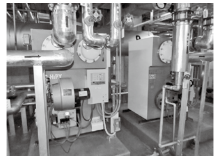
温泉館のボイラー交換
