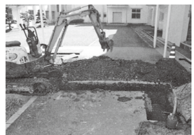
漏水箇所を修繕
