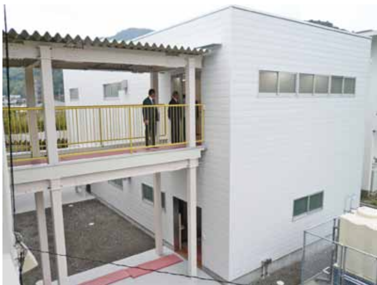
建設された2階建ての便所棟
