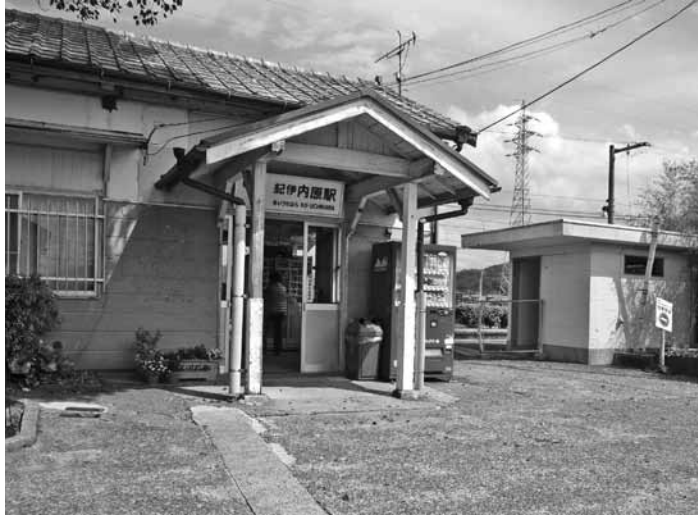
紀伊内原駅舎とトイレ
