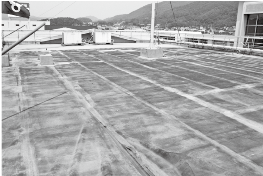
役場本館屋上の防水対策を施工する箇所
