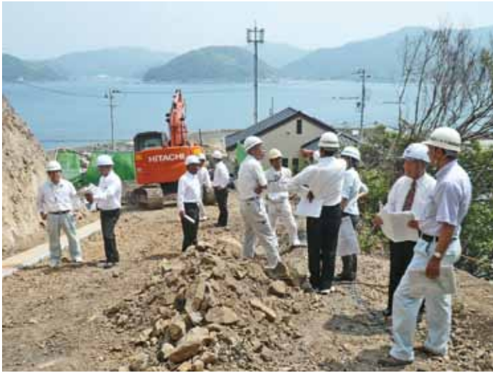
急傾斜地崩壊対策事業の現場での説明（阿尾）
