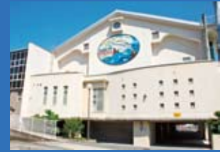
比井小学校屋内運動場
