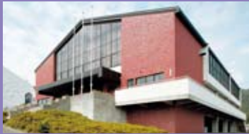
日高中学校屋内運動場
