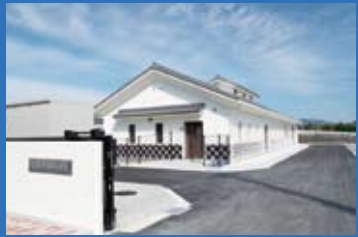
高家下水処理場
