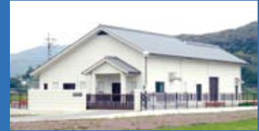
小池下水処理場
