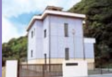
比井下水処理場
