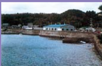
比井漁港防潮堤工事
