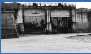
産湯川の樋門
