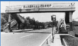
国道42号線の歩道橋
