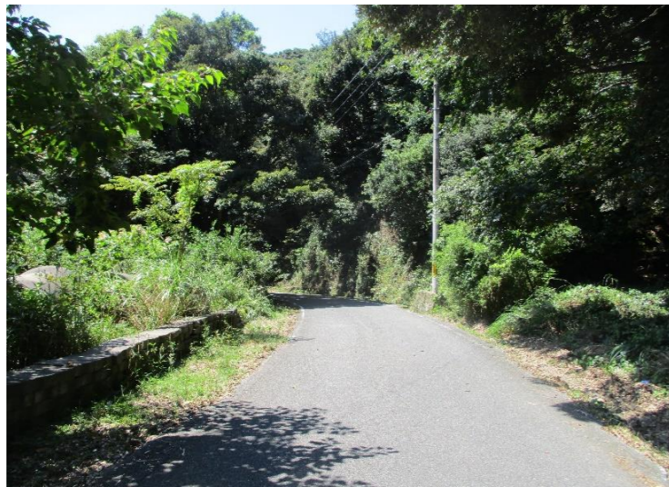
① 県道柏御坊線（上志賀～柏） 幅員が狭く急カーブが多い
